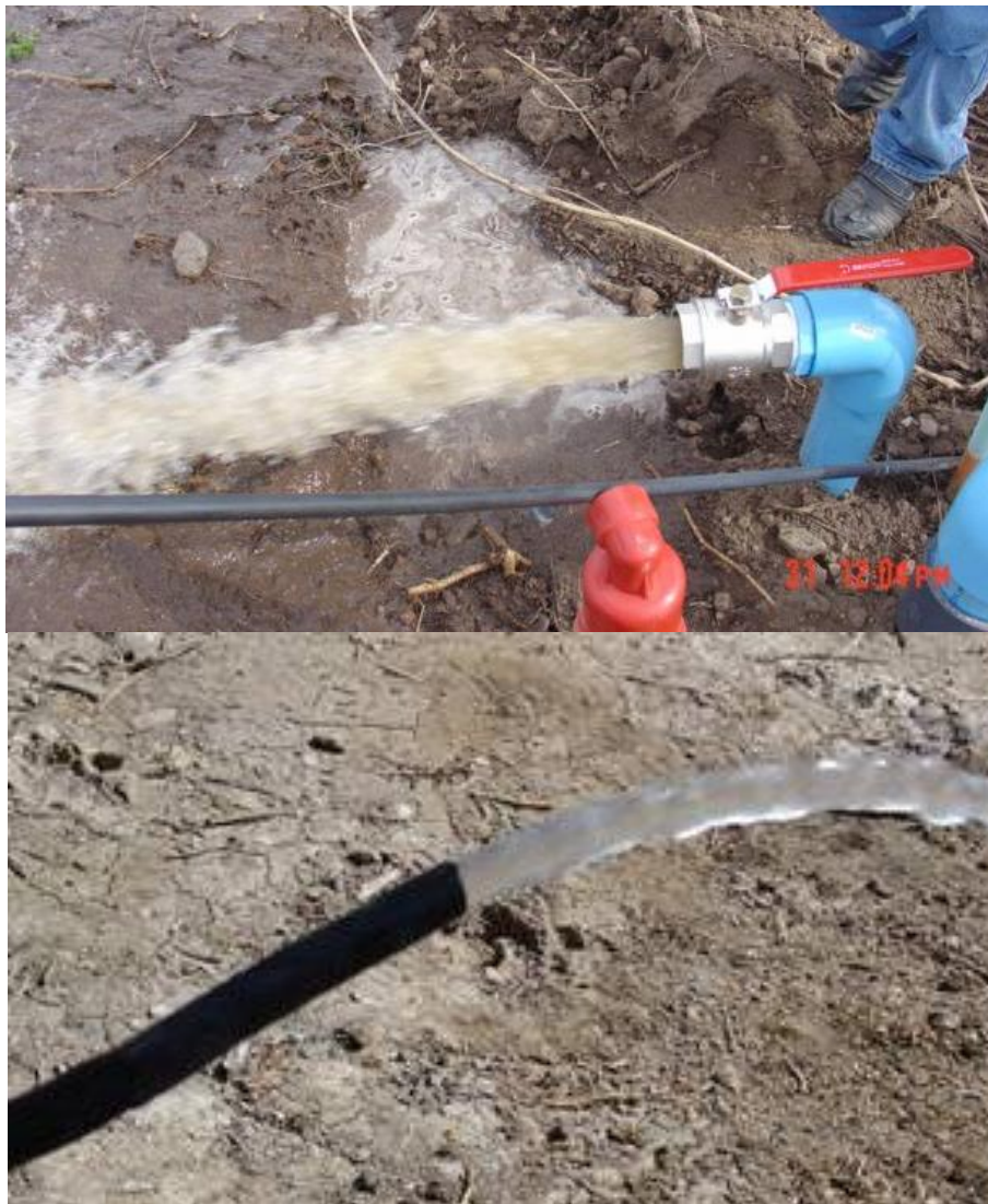
Figura 6. Lavado de la red de riego con eliminación del agua en la submatriz o terciaria (izquierda) y fin de laterales (derecha).
